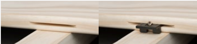
Ter plaatse groeven aanbrengen, met profielgroeefreesmachine (type Lamello®) of bovenfrees.
