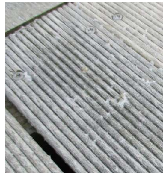
8.4 Een geribbelde plankprofiel heeft de neiging tot opeenhoping van vezels
