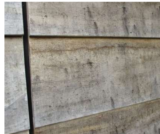
Een ruw bezaagd oppervlak bevordert aangroei
