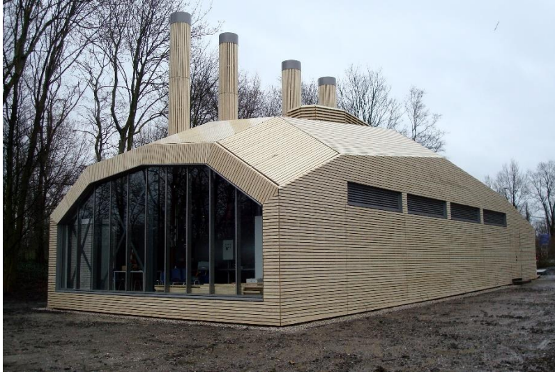
Ketelhuis met Accoya gevelbekleding, Amstelveen.
